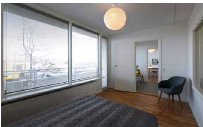
Nye vinduer og efterisolerede vægge skal modvirke træk.
